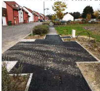
Travaux réalisés Mi-octobre 2021
