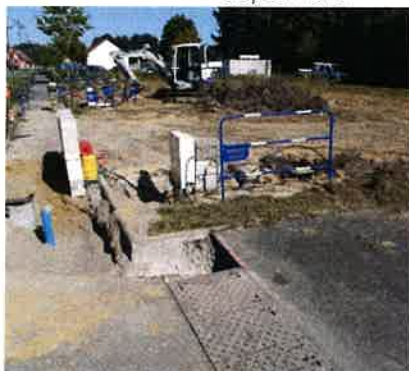
Travaux en cours Septembre 2021
